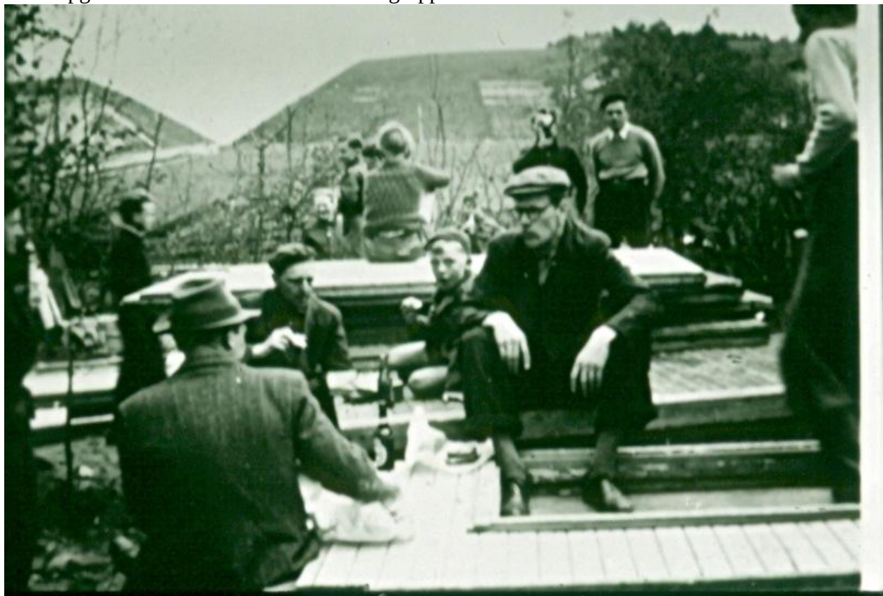
Pilehytten (en barak fra Kløvermarken) skal sættes op i Pilehaven. Orla sidder med front denne vej.
